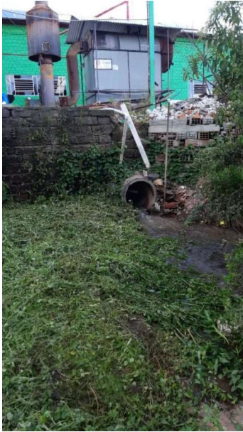
Figura 4. Arroio canalizado à montante, o qual passa abaixo do prédio da lavanderia.
