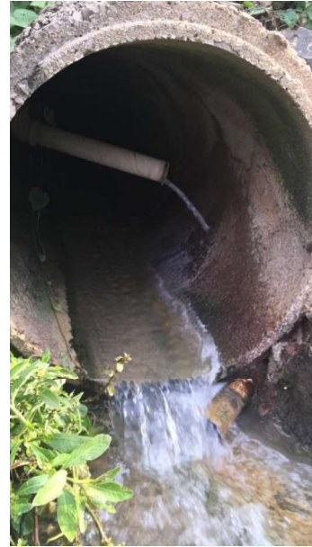
Figura 5. Detalhe para a canalização do arroio com presença de um cano desaguando no mesmo.
