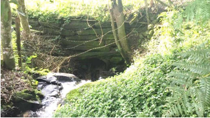
Figura 8. Arroio canalizado à jusante.
